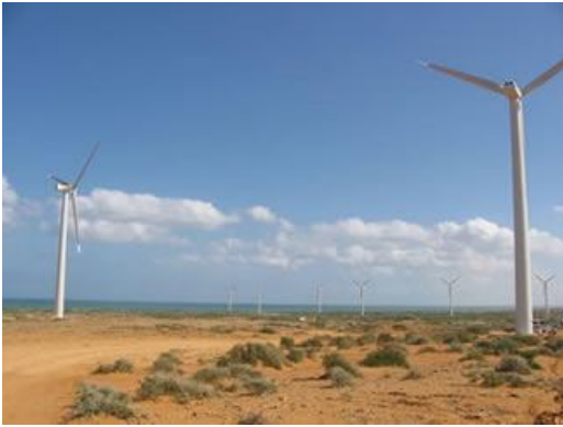
Figura 1. Aerogeneradores de parque Jepírachi
